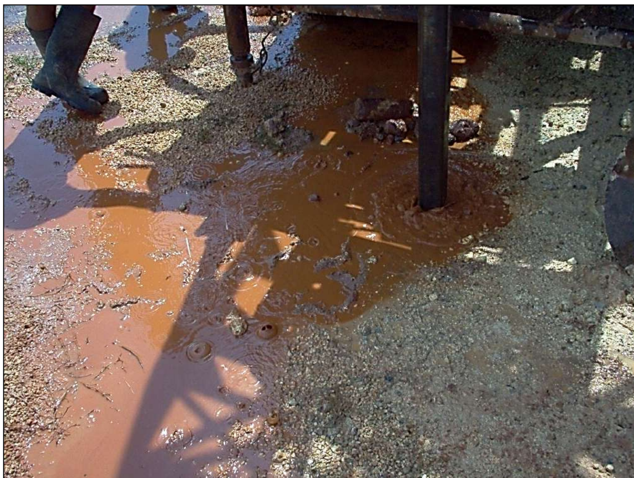
Fig. 19. Lavado a presión con inyección de agua a presión durante la perforación. Obsérvese el color rojo del agua de emergencia, debido al acarreo de arcillas eluviales del tipo de terra rossa.
