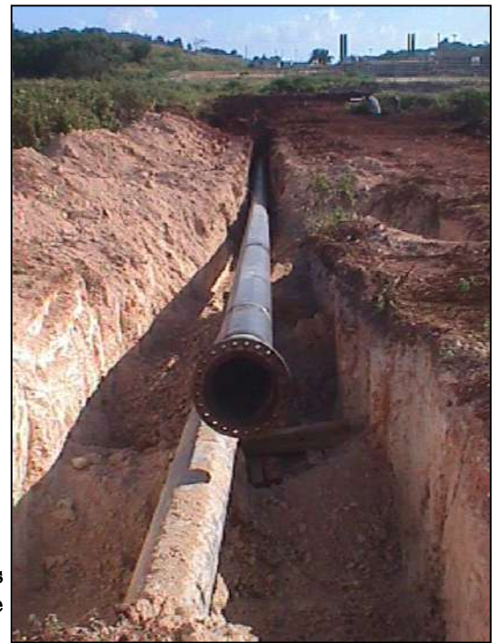
Fig. 13. Excavación que muestra el escaso desarrollo local de horizontes de suelo por eluviación (derecha de la figura.) en los alrededores del perímetro norte de la Planta de Gas de Puerto Escondido.
